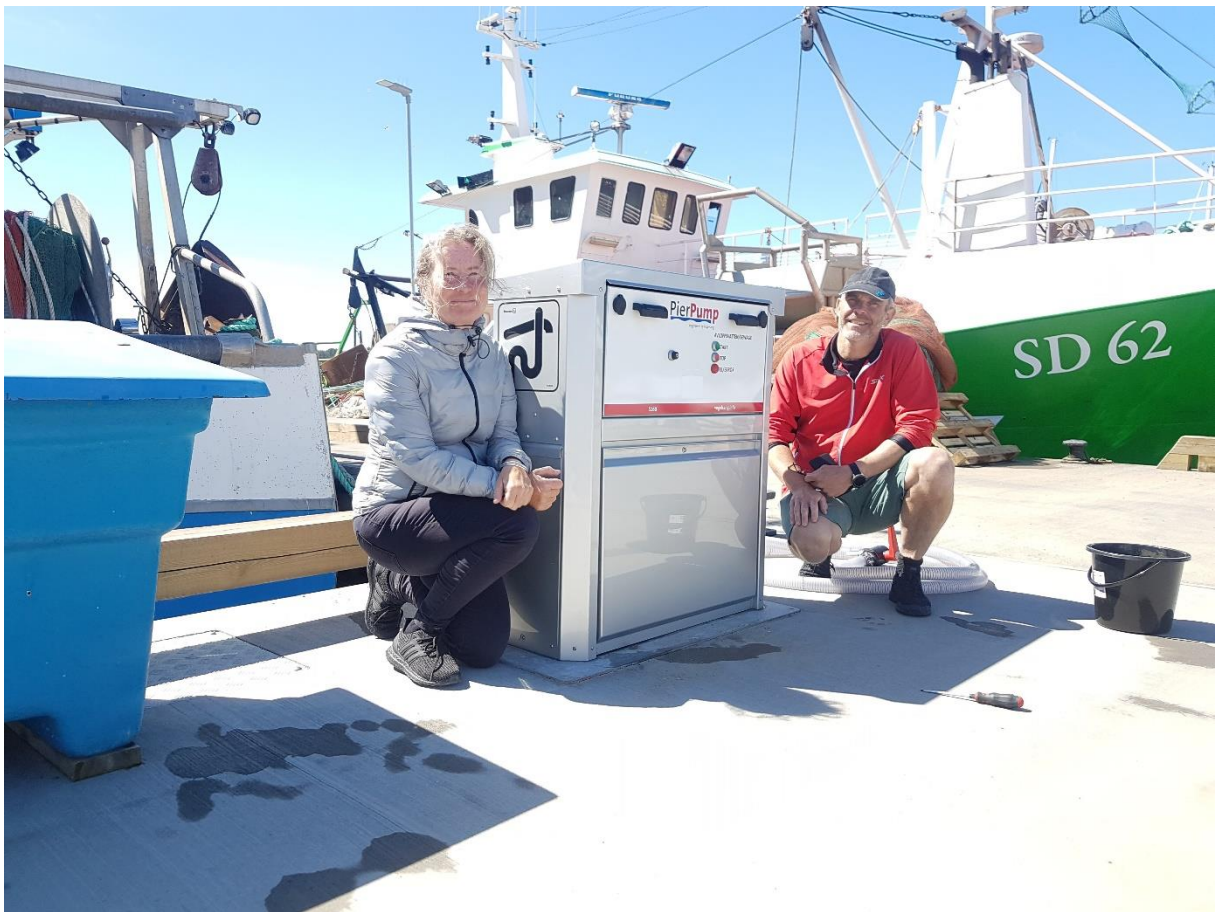
Bilde av et septikmottak for fritidsbåter ved Grebbestad i Sverige. Foto: VAV
