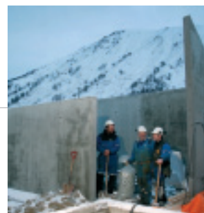
Fjøsbygg, Bjørnskinn - Andøy
