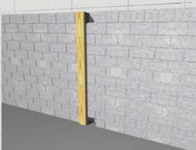
Slå eller skjær hull i muren for forankring
