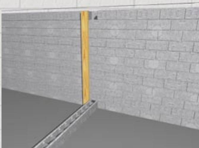
Sett opp en "styreplank", husk armering fra yttervegg og inn i deleveggen.
