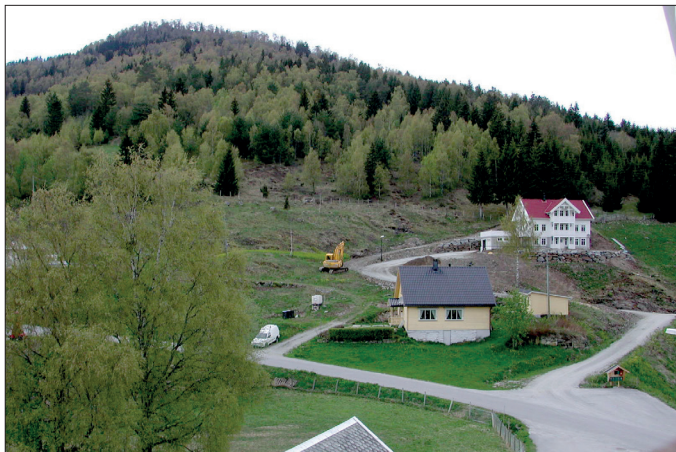
Her er vegen opp til fellesarealet ferdigbygd. Mai 2005.
