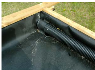
Innvendig takrenne ferdig montert
