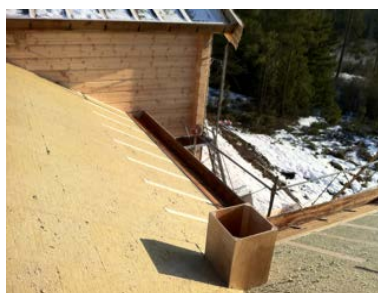
Kasse til muring av pipe
