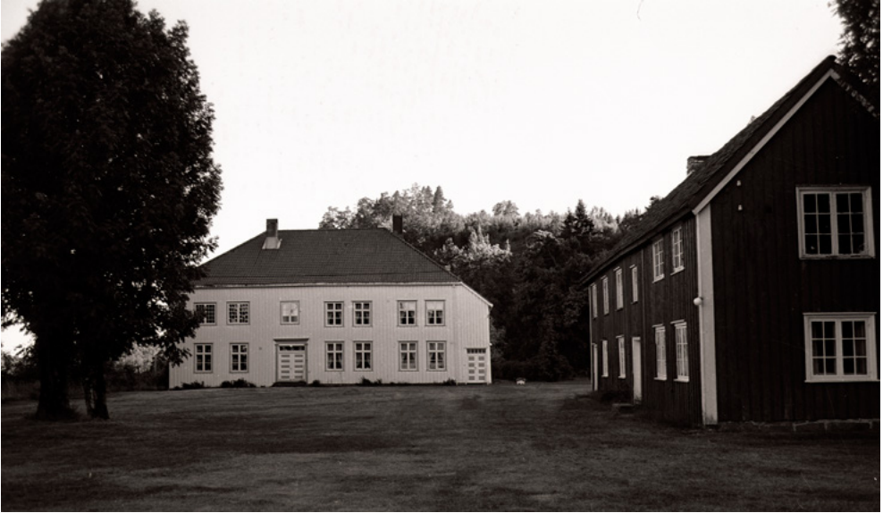
Holt Prestegård. Seminarsalen til venstre i 2. etasje. Foto: Olav Breen
