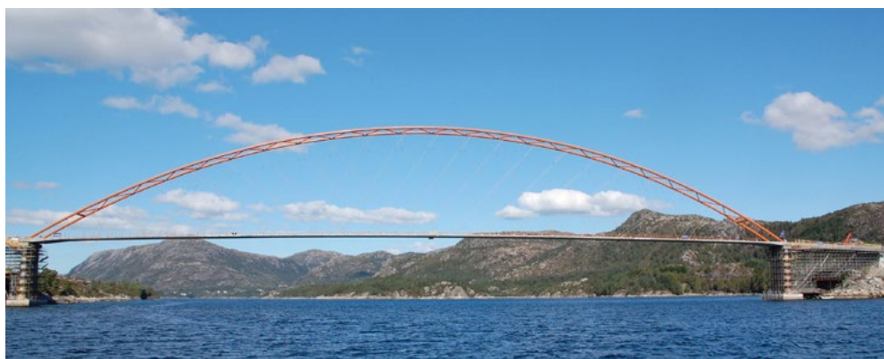
Fig. 1. Brandanger bru i Gulen før rekkverket vart montert. Opna i år 2010. Spennvidde 220 m.
