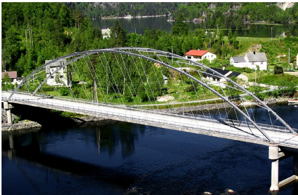
Fig. 10. Bolstadstraumen Bru vart ferdig til jul i 1963. Spennvidde 84 m.
