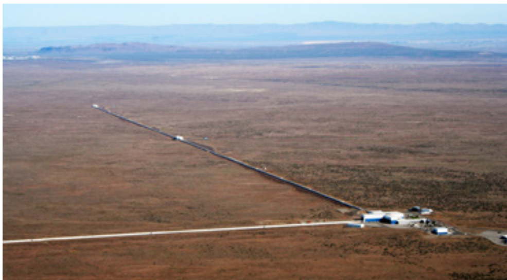
Figur 1: LIGO-laboratoriet i Hanford, Washington. De to armene står normalt på hverandre, og kraftige laserstråler sendes ned hver arm for å måle om lengden på hver arm endrer seg når en gravitasjonsbølge passerer. LIGO består av to identiske interferometre, det andre er plassert nær Livingston, Louisiana.
