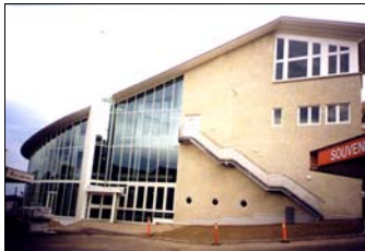
På Eilert Sundt Videregående Skole (over) ble det lagt NM-Betong på trapperepoer og i ganger i atriet (til høyre).
