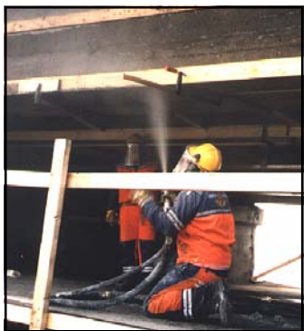
Sprøyting med høyfast betong under Mandal Bybro.
