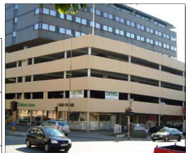
Etter inn- og utvendig rehabilitering av P-huset Parko, Kristiansand i 2003.
