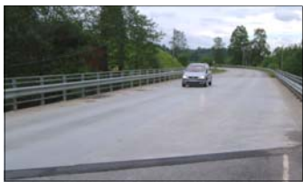
Krokfoss bro etter utførelse.
