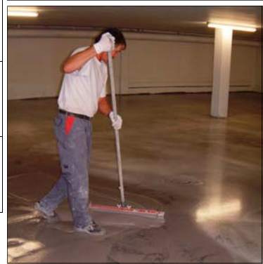
Utførelse av 5-10 mm belegg av høyfast betong på Vestre Torv P-hus, Kristiansand i 2004.
