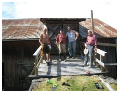
Brødrene Staum, Hammershaug og Reistad monterer takrenner
