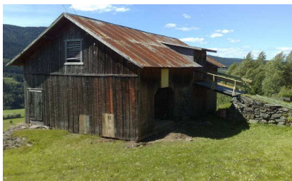
Stallvegger, vognskjulgulv restaurert av Staum, Staum og Stensrud Foto: KH Reistad
