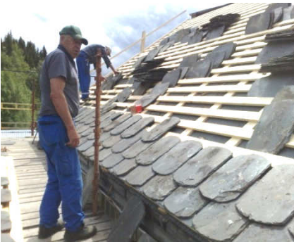
Skifertekking på hovedbygning (Foto K.H. Reistad)
