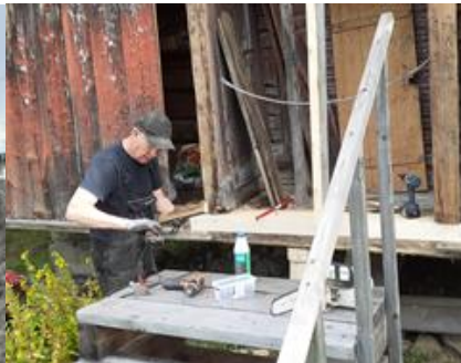
Forsterka bærebjelke under stabbursgang. Foto: khr
