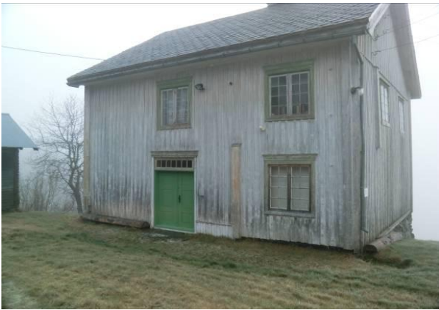
Opprinnelig ytterdør kopierte av E. Paulsrud. Foto KH Reistad
