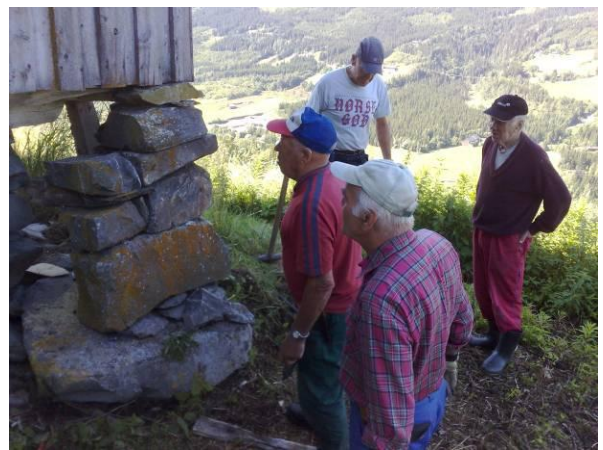
Staum, Staum, Stensrud og Hammershaug restaurerer stallpilar. Foto KH Reistad
