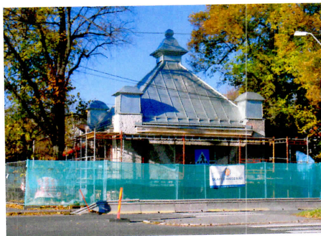
Trafoen pusses opp
