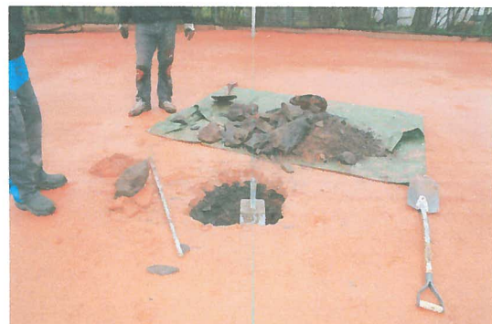
Nytt nettfundament på bane 2
