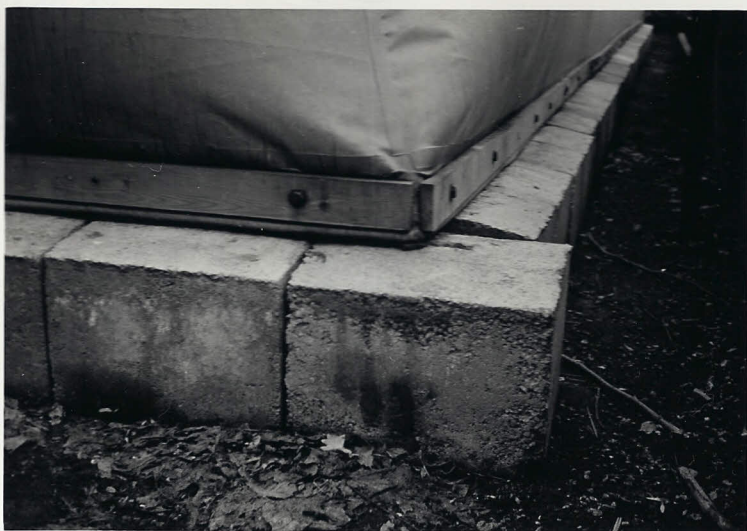
FORANKRINGSBLOKKENE MED BUNNFESTE FOR PLASTBOBLA
