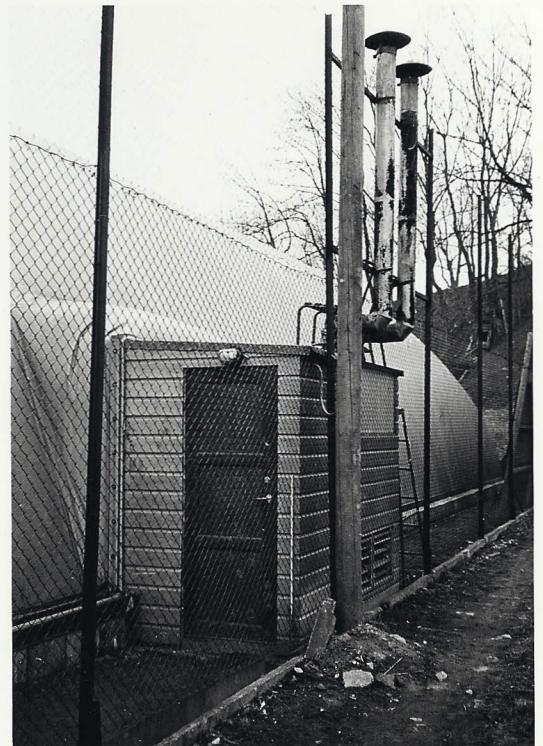
FYRROHMET MED SLUSEINNGANG TIL PLASTHALLEN
