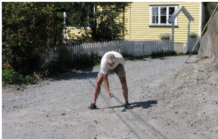
Posisjonsbestemmelse – rett ned her ligger kabelen
